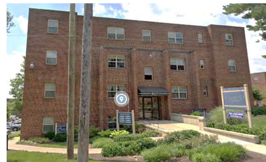
Apartamentos de mediados del siglo en Piney Branch Parkway
